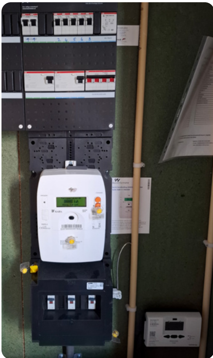
Groepenkast met elektrameter, slimme meter en rechtsonderin de warmtemeter van HVC
