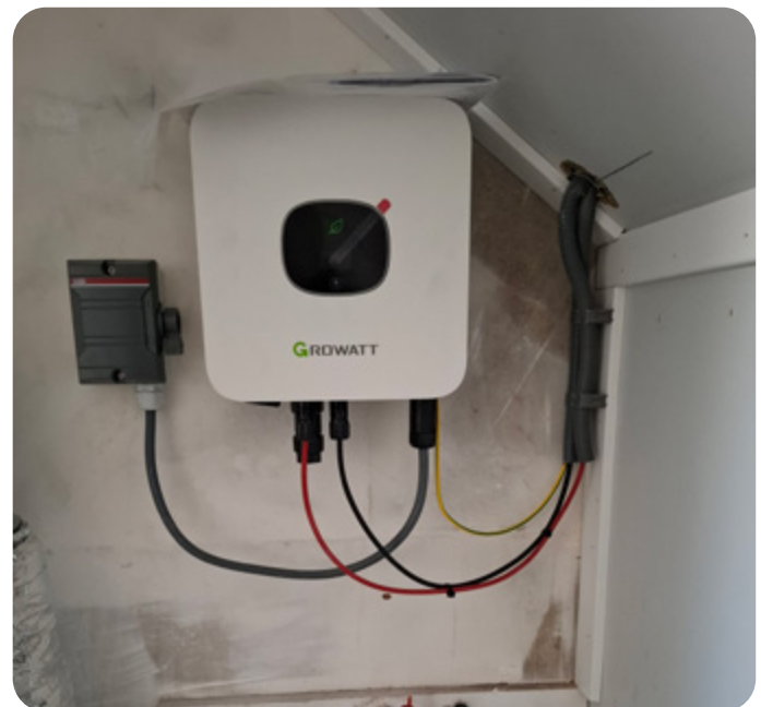
Omvormer van de zonnepanelen
