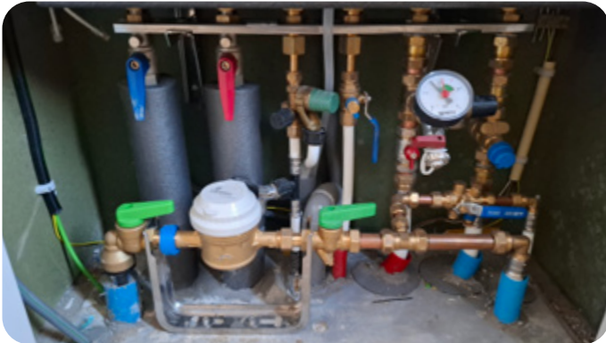
Watermeter met de hoofdkraan
