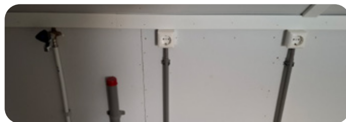
Aansluitingen voor de wasmachine en wasdroger
