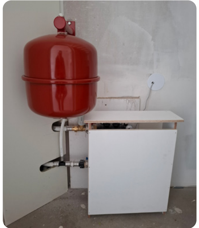
Verdeelunit van de vloerverwarming met de beschermbak
