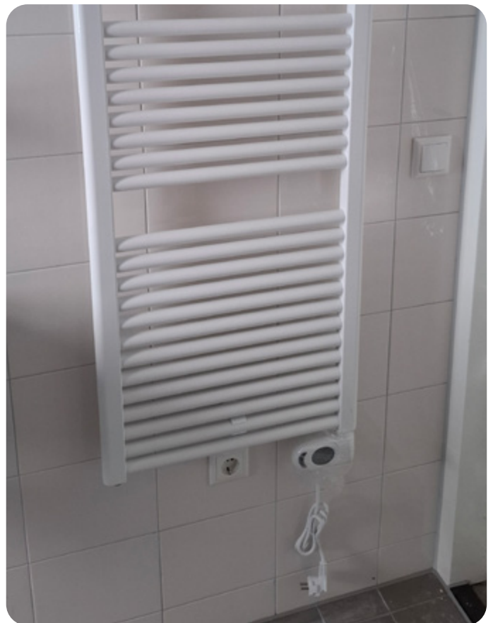
Elektrische radiator in de badkamer
