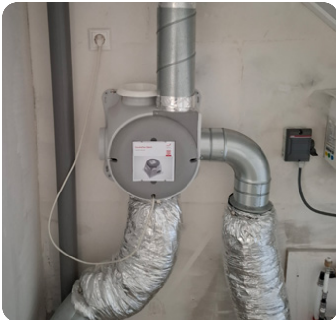
Mechanische ventilatiebox
