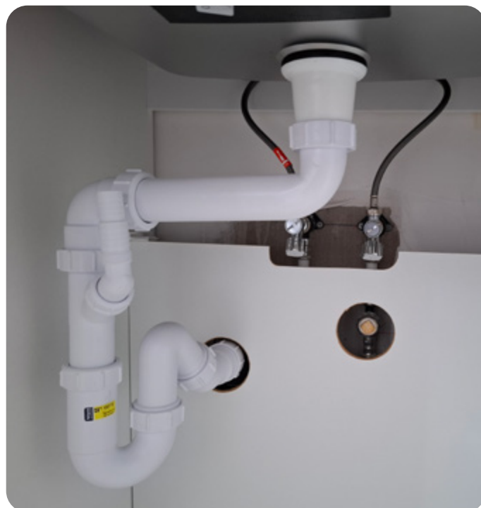
T-stuk voor wateraansluiting vaatwasser
